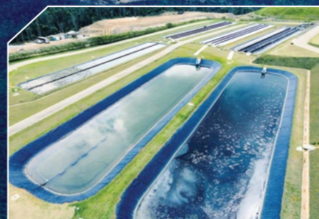
Estação de Tratamento de Efluentes
