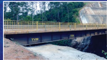
Ponte de Acesso
