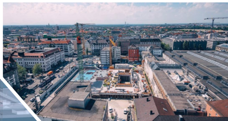
ACIMA: Obras em andamento na principal estação de trens de Munique, em maio de 2023
